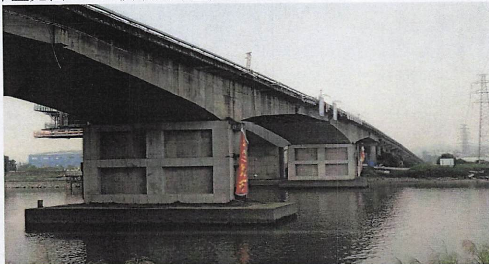
图 1-1 桥梁整体立面照片
