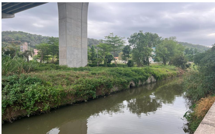
牛压涌现状河道
