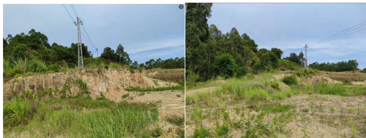
临站二路（进港路-进站南路）架空 10kv 高压电缆
