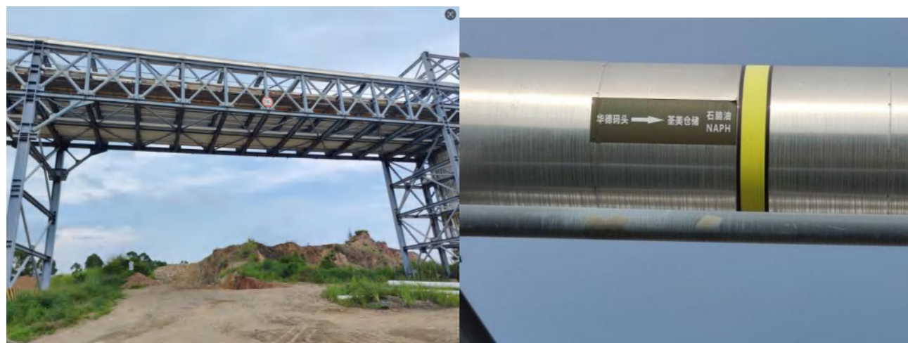
现状输油管道
