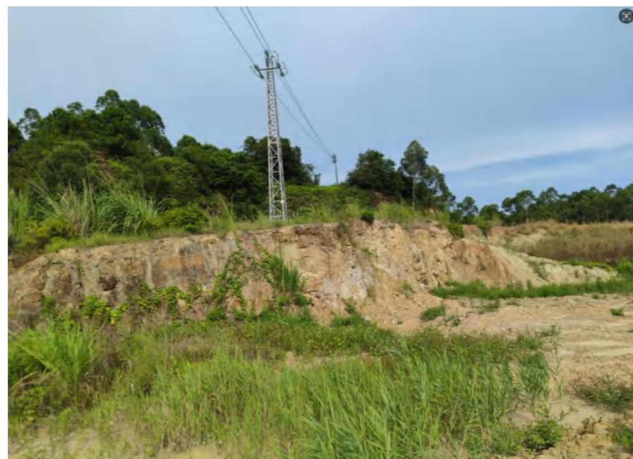
架空、埋地 10kv 高压电缆
