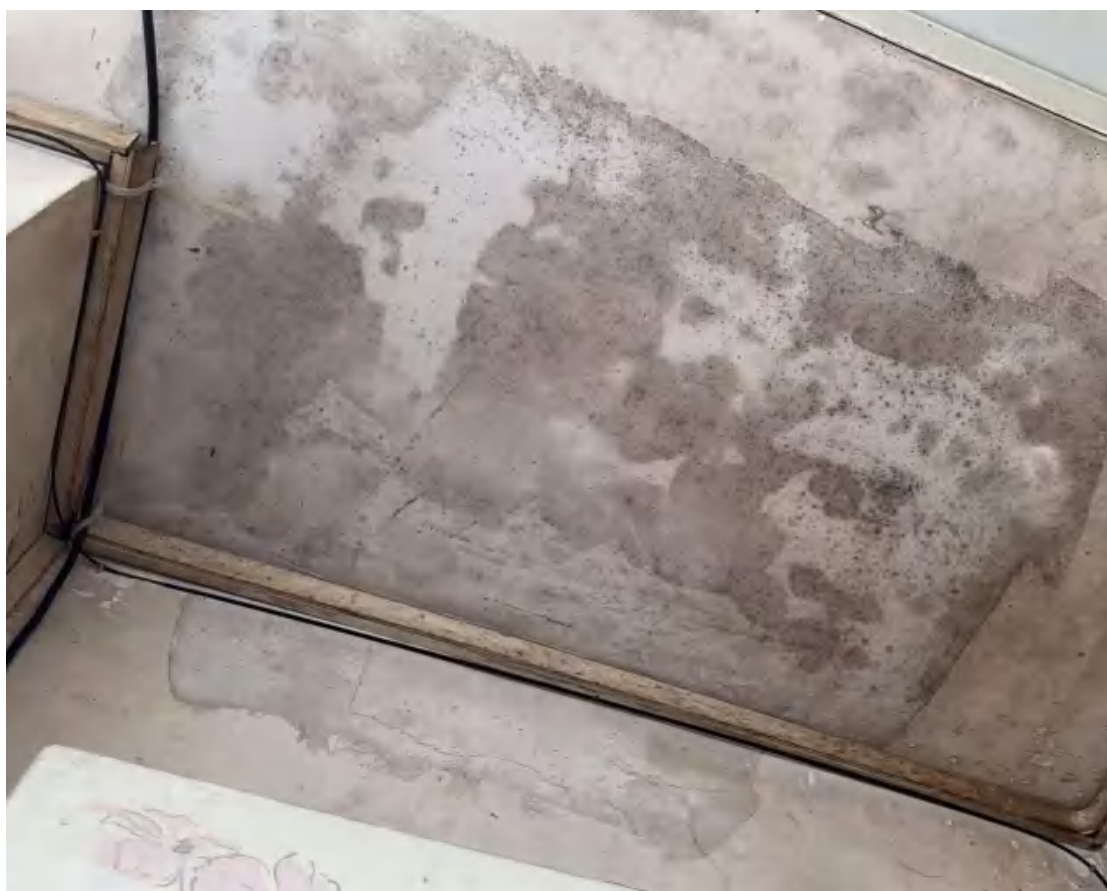
图 3.1-37 五指山入口综合服务中心建筑现状
