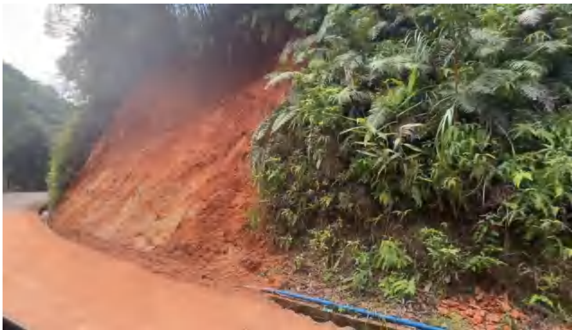
图 3.1-46 五指山至月牙湖道路边坡塌方现状图
