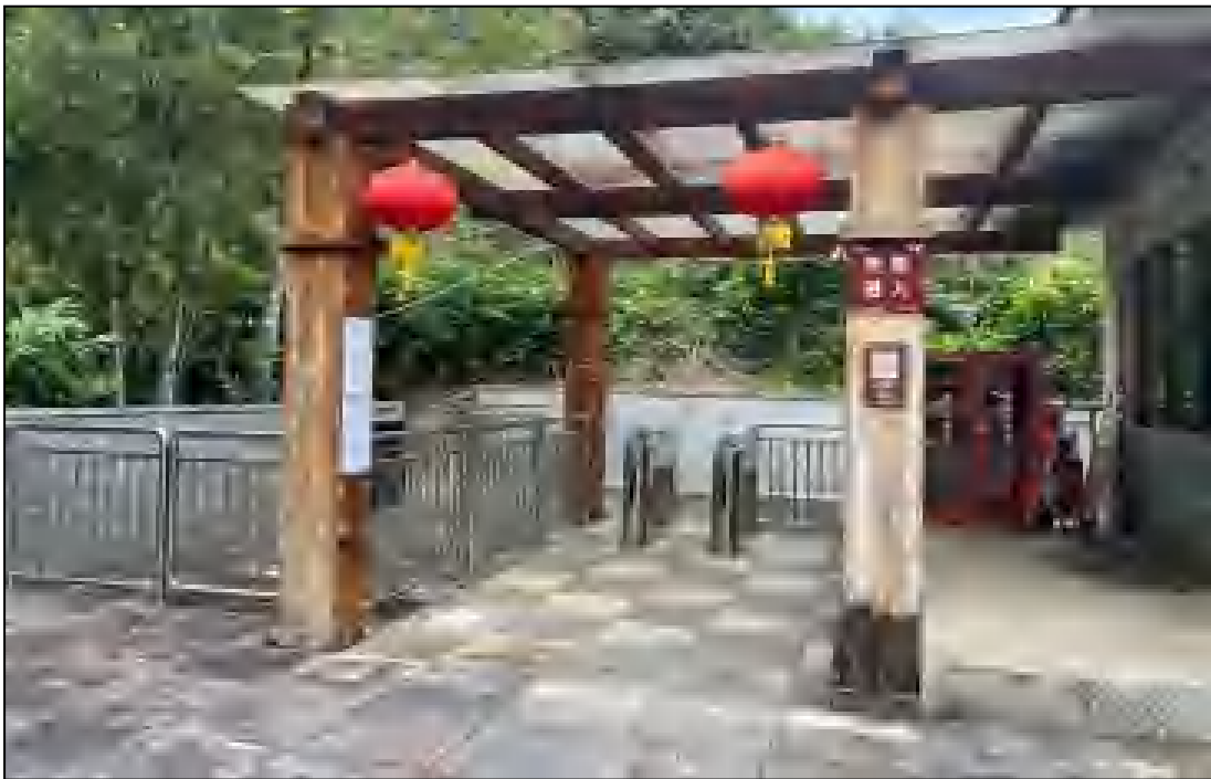
图 3.1-41 五指山次入口检票口现状
