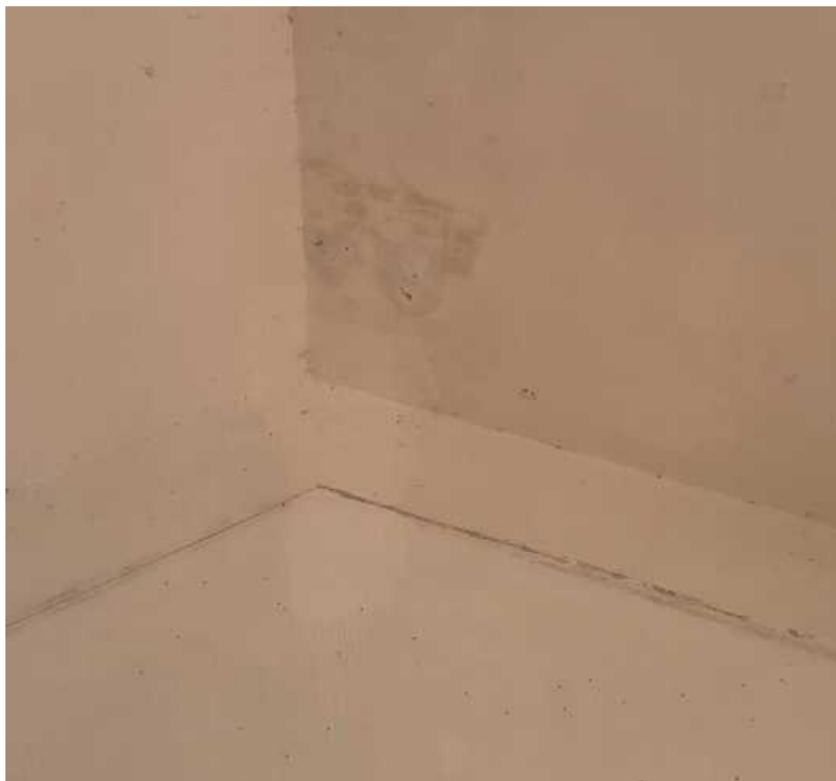
图 3.1-43 月牙湖服务建筑驿站内部
