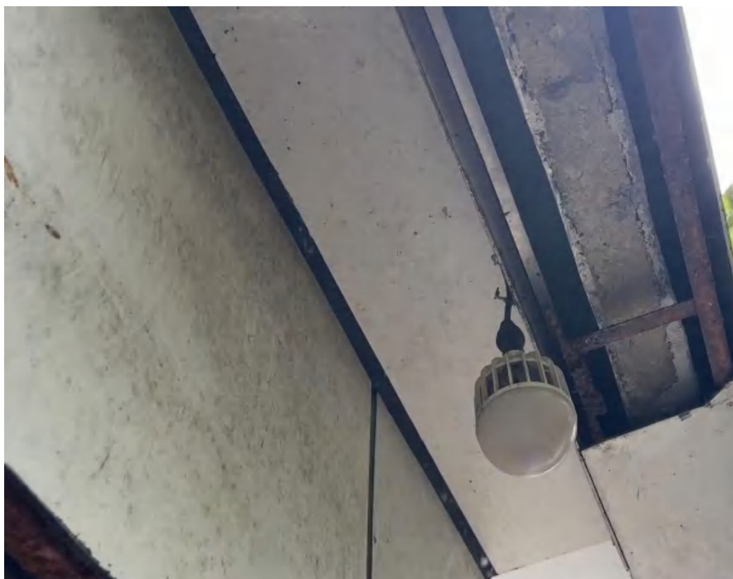
图 3.1-36 五指山入口综合服务中心建筑现状
