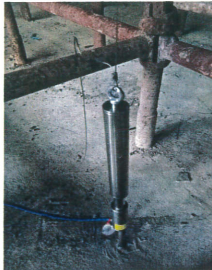
位移计安装现场图
