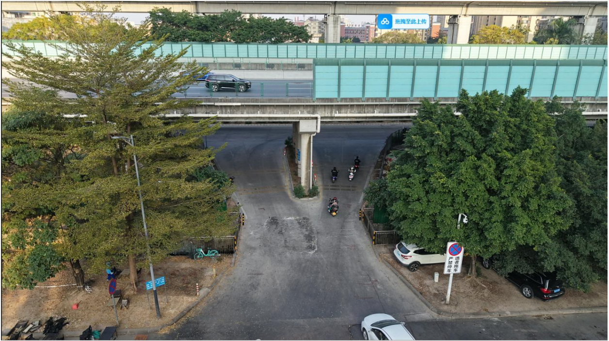
图2 航拍图（桥下的6个过水涵洞要改建）
