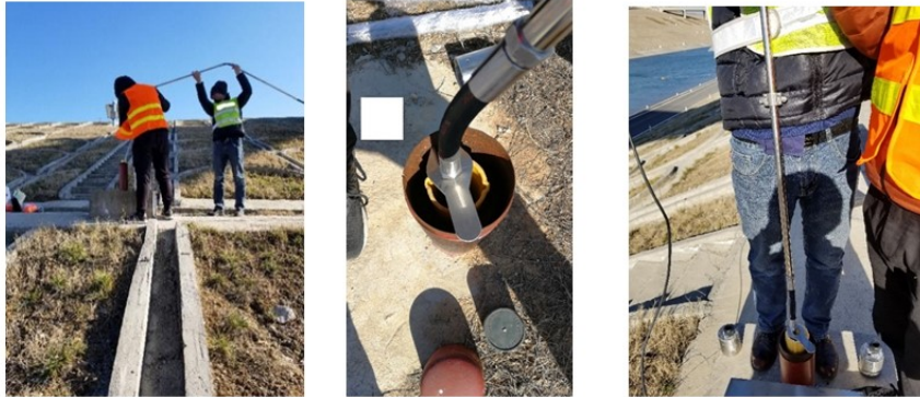
步骤 2: 阵列位移计往下面放，下放过程中中途可用卡件固定
