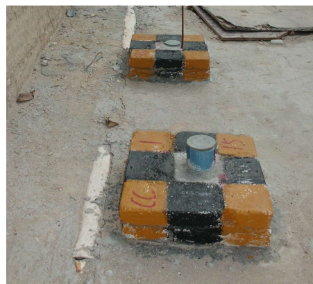
图 17：测斜保护墩示意图
