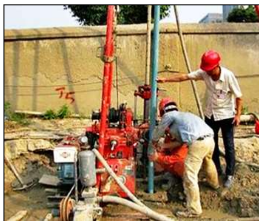
图 16：测斜管埋设示意图
