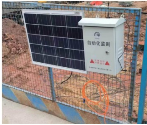
图 20：固定式测斜仪安装完成图
