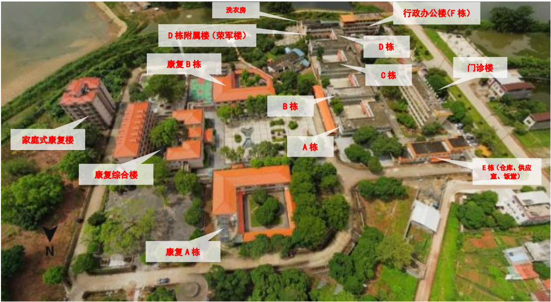
图 3.1-6 医院现状建筑分布航拍图
