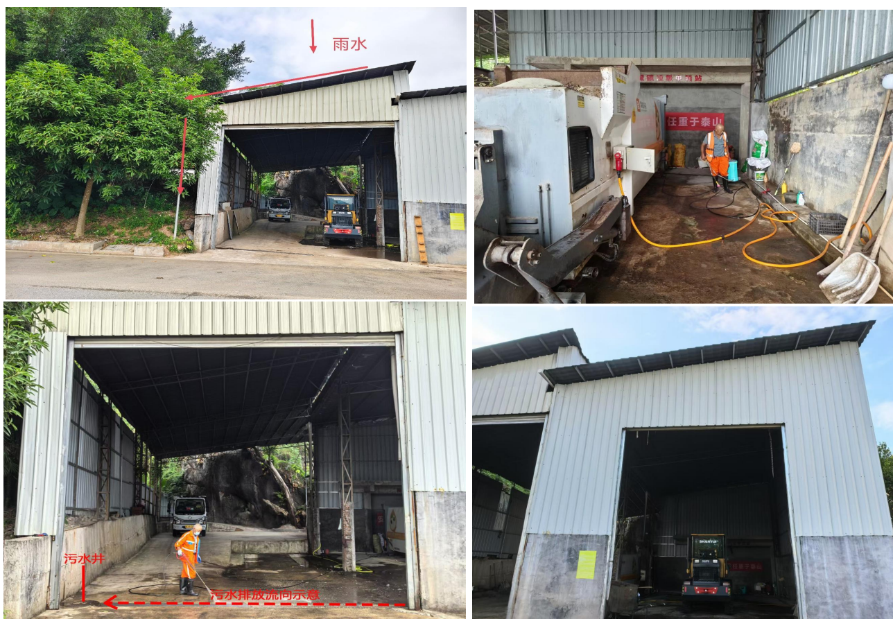
柳城镇原垃圾中转站(现状照片)
